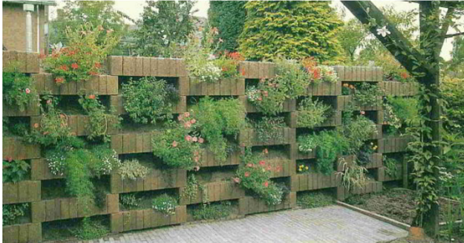
Esempio di barriera antirumore con verde integrato
