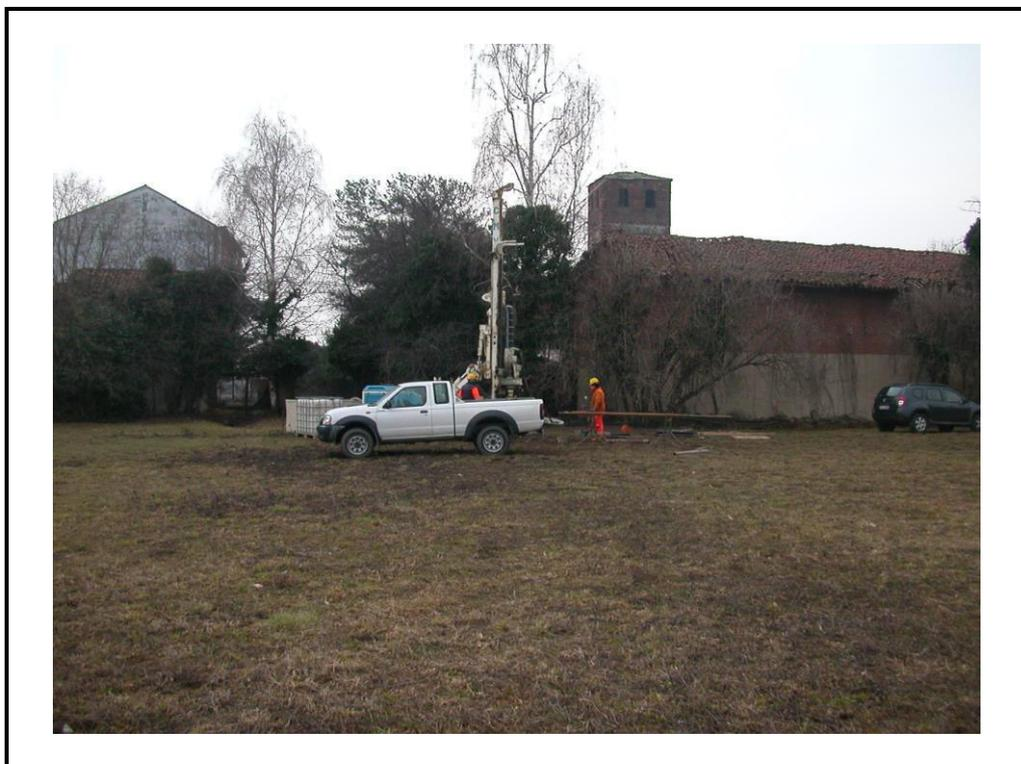
**Foto 4:** Posizionamento sondaggio S1.
