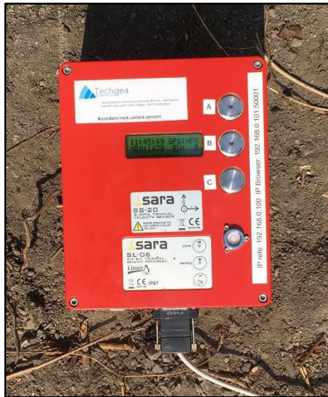
Figura 2 – Strumentazione utilizzata – Registratore sismico SL06
